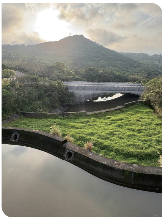
圖 3-1：校園內的攔沙滯洪池
