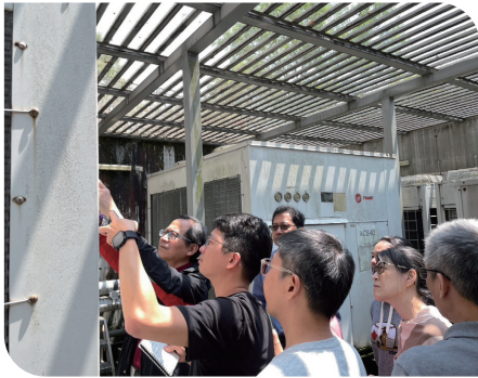
圖 2-13：確認校園冰水主機能源耗損、冷媒型號與冷媒填充量
